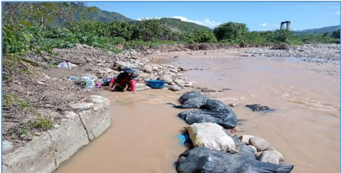
FIGURA N°01: INFRAESTRUCTURA DE RIEGO CANAL DAMIANA COLAPSADO POR INCREMENTO QDA. TALAQUE
